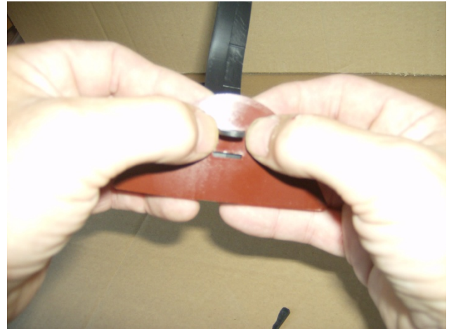
Abdeckung mit beiden Daumen fixieren (Schlitz je nach Ziegelöffnung verwenden!)
